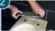
Coloque a placa de fixação com os novos parafusos.
