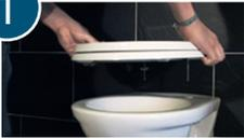
Retire o assento e a tampa existentes desapertando os parafusos.
