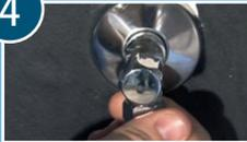
Conecte o tubo flexível da unidade ao abastecimento de água.
